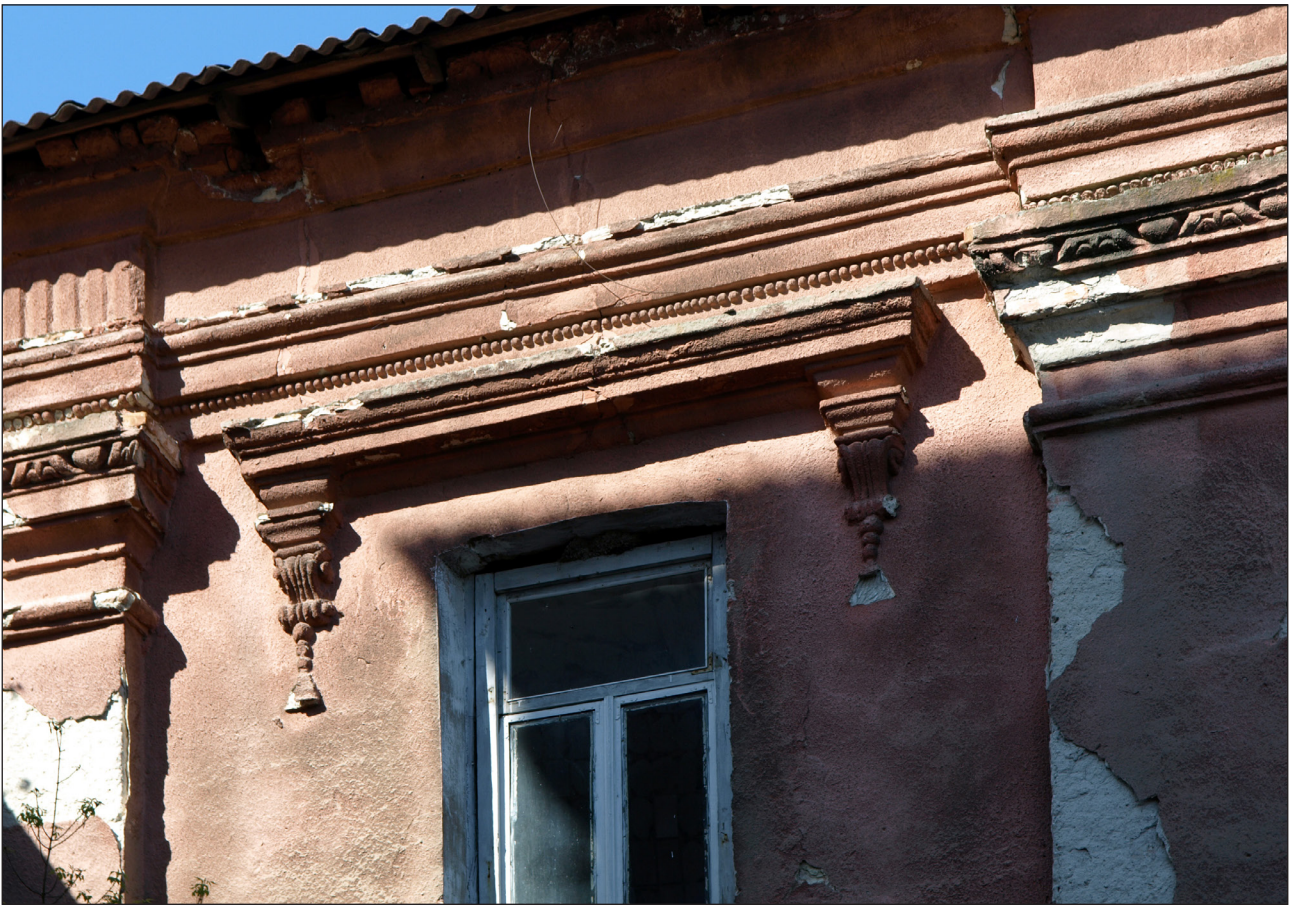
Рис. 17. Декоративне опорядження монастирського корпусу. Профілювання карниза та надвіконного сандрика. Фото автора, 2008 р.
